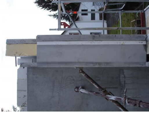
Abbildung 1: Thermowand Fensterbewehrung
