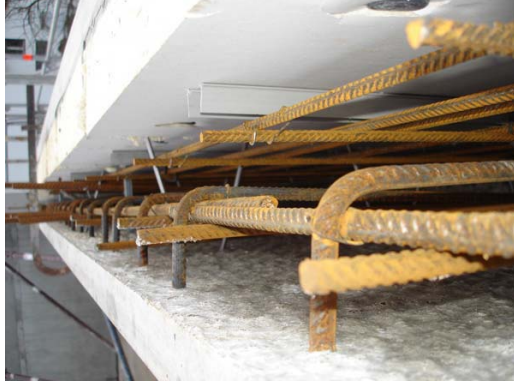
Abbildung 2: Blick in Thermowand
